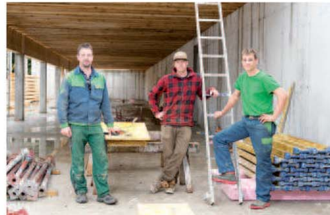
Sie unterstützen Thomas Ließ tatkräftig auf der Baustelle: Maschinenring Bauhelfer Michael Schöpp, Oberprem (re) und Norbert Weißenbacher, Untergrünweg, beide aus Gaissau.
