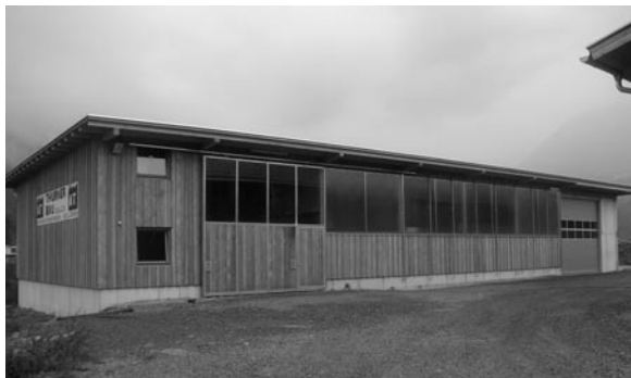
Das neue Betriebsgebäude im AZW Imst
